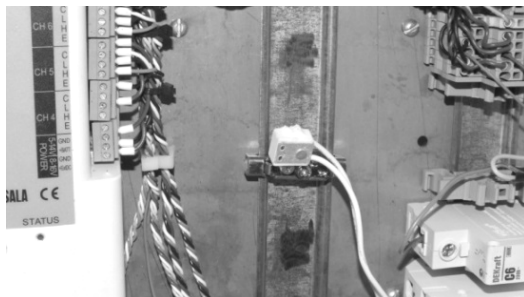
Рис. 1. Доработанное крепление патрона
