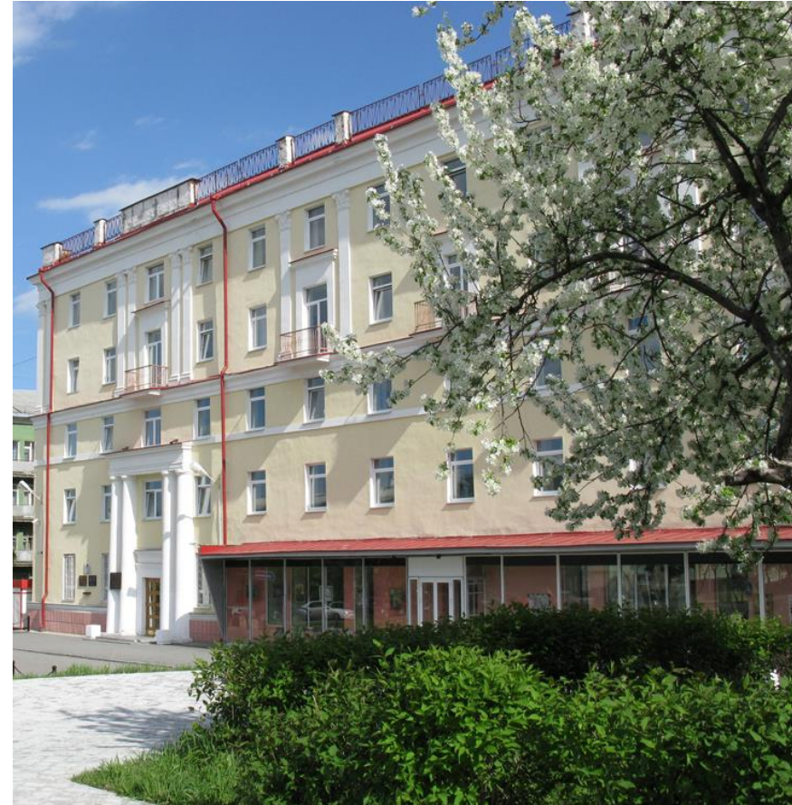
Здание Управления РФЯЦ–ВНИИТФ
