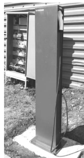
Рис. 4. Установленная зарядная станция
