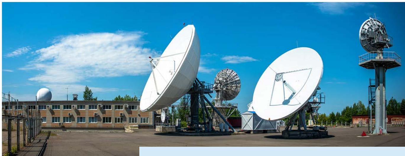
С десяток антенн диаметром от двух до 13 метров нацелены в космос. Контрольно-измерительные станции, частью которых они являются, обеспечивают круглосуточный приём и передачу данных с российских спутников гражданского назначения и других объектов ракетно-космической техники, находящихся на околоземных орбитах.
