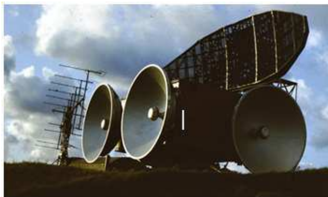
Рисунок 1 – Приемные системы МРС сантиметрового, дециметрового и метрового диапазонов г. Курильск (о. Итуруп)
