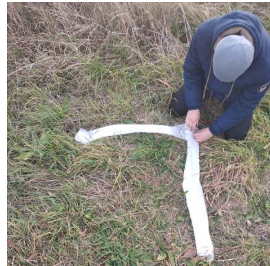
Рис. 2. Закладка опознавательных знаков
